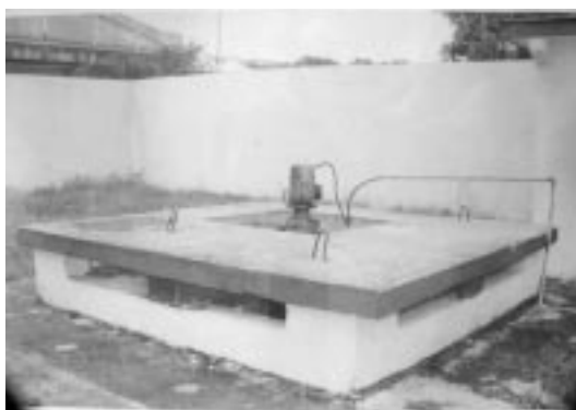
Tanque para segregar corriente, homogenización y ajuste de pH.
