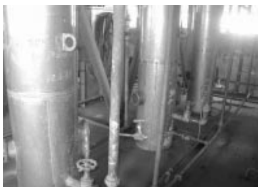
Fig. 3. Tratamientos de desinfección. Torres de ozonización.
