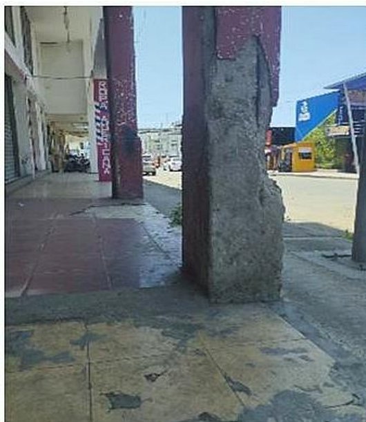
Fig. 4. Afectaciones por corrosión atmosférica en los aceros de refuerzo en la columna de la estructura EEB
