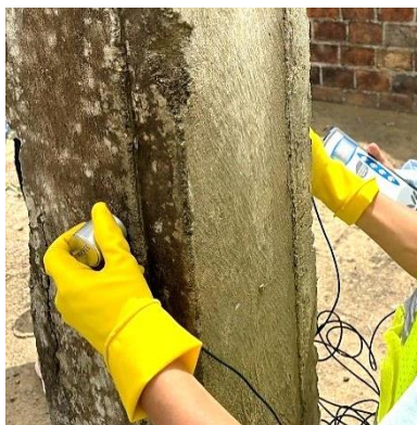
Fig. 4. Ejemplo de medición de la VPS en una de las columnas.
