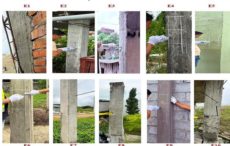
Fig. 3. Ejemplos de cómo fueron ejecutados los ensayos de Esclerometría en las columnas de las 10 estructuras.
