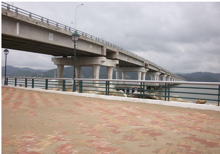
Fig.1. Puente "Los Caras" que une Bahía de Caráquez con la ciudad de San Vicente, Ecuador.
